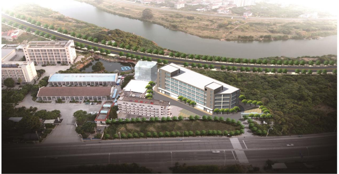
莆田市盛世八达光电科技有限公司厂区鸟瞰图
